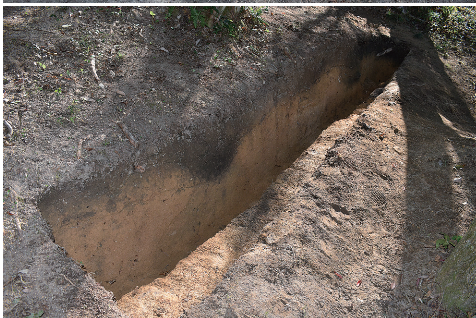
(3) 長者原窯跡群 4トレンチ東壁土層 (北西から)
