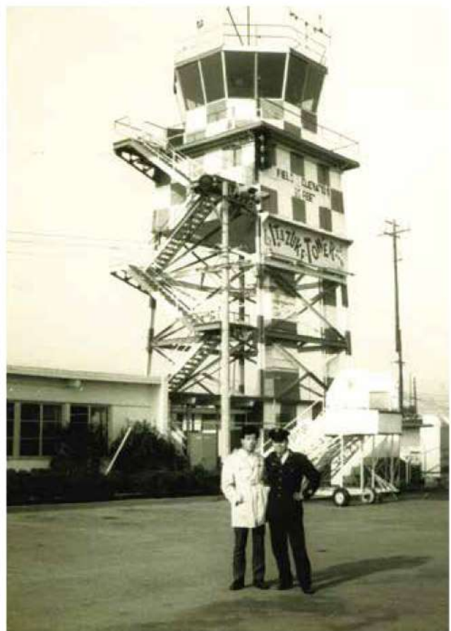
板付飛行場のコントロールタワー（右側が田中さん）
